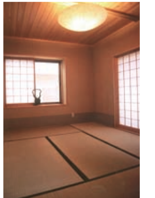
中霧島壁で仕上げたタタミの間。据には塗壁の保護と意匠から和紙を貼った。(高尾の家)
