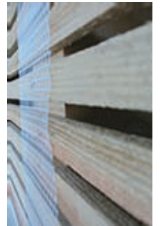
柱、間柱の部分は、木摺りの上から寒冷紗を張る。
