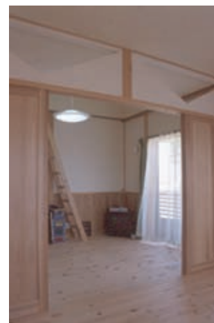
お子さんの部屋。漆喰仕上げの壁、天井。腰壁と建具は杉、床は桧の無垢板。部屋を通る風もさわやか。
