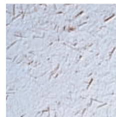
漆喰わら入り仕上げ
