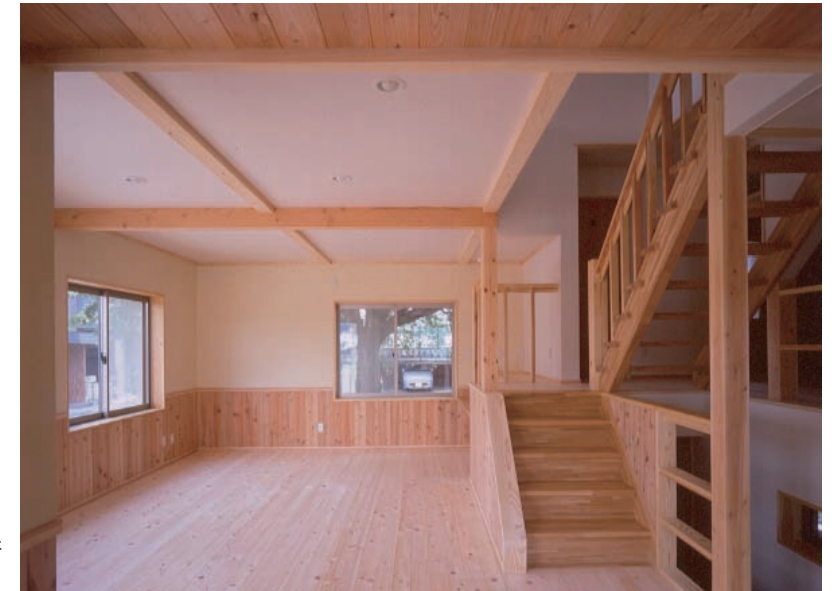
珪藻土壁と杉の腰板貼りで仕上げたリビング。腰板は汚れ易い足元まわりを保護することにも有効。(朝霞の家)
